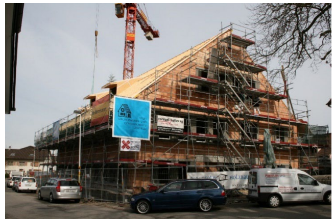
Abbildung: Das Kirchgemeindezentrum im Rohbau
